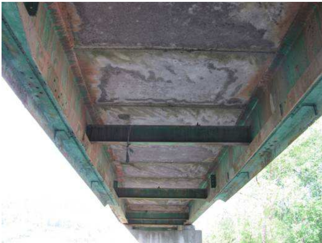
Fot. 3 Konstrukcja nośna
