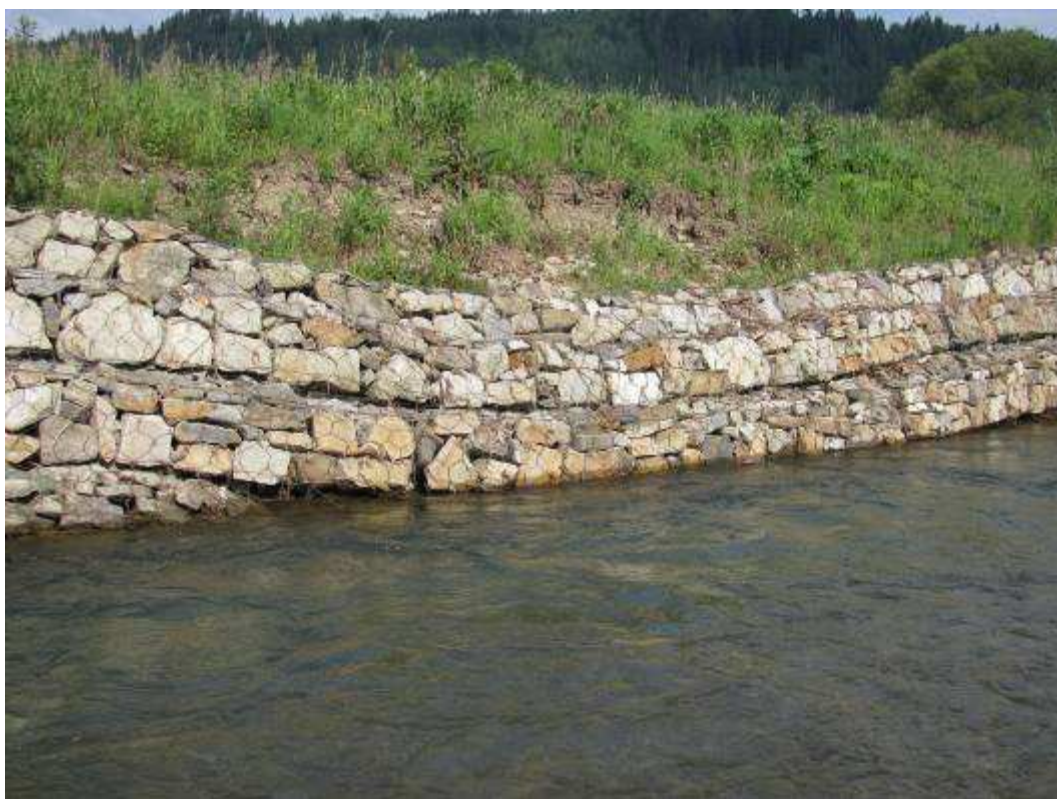
Fot. 8 Podmyte i zdeformowane umocnienia z koszy siatkowo kamiennych.
