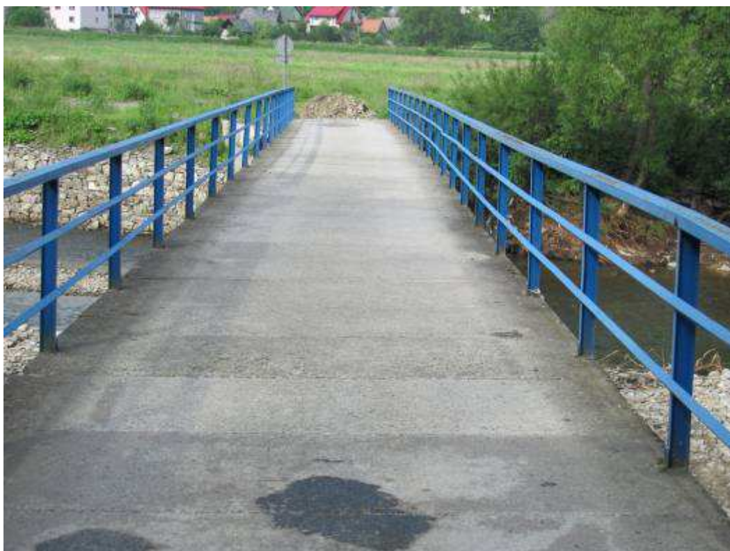
Fot. 1 Widok ogólny na most
