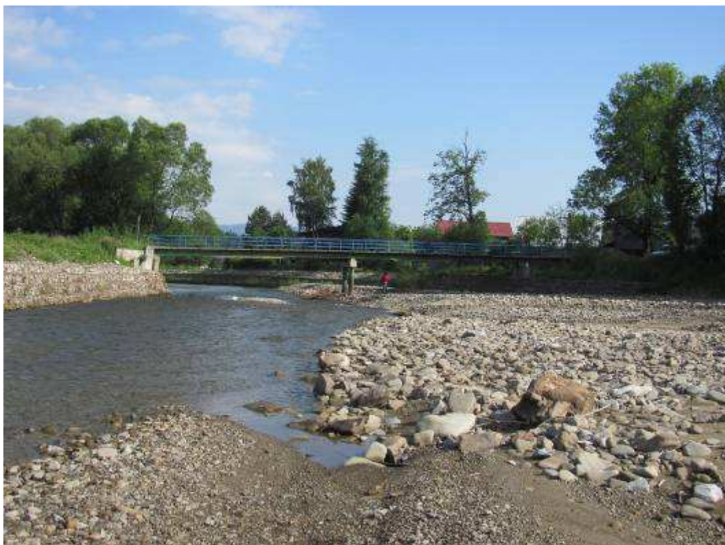
Fot. 8 Nagromadzony żwir rzeczny powodujący nakierowanie nurtu rzeki w str. lewego brzegu oraz przyczółka.
