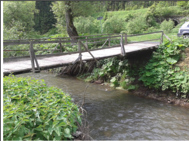
Widok ogólny mostku
