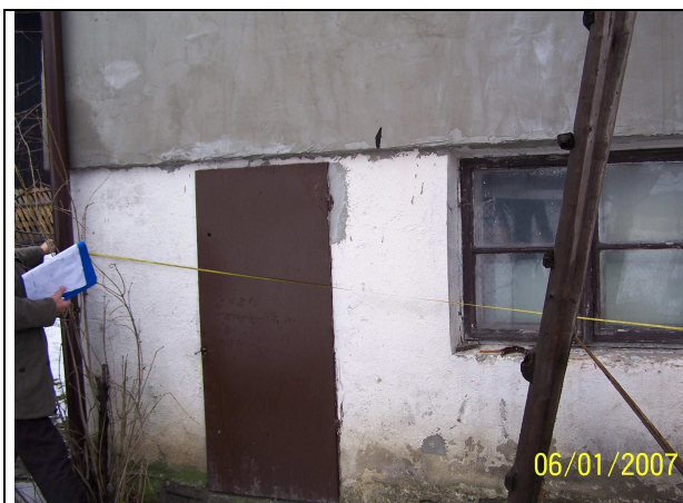
Przyziemie dobudówki widok od południa
