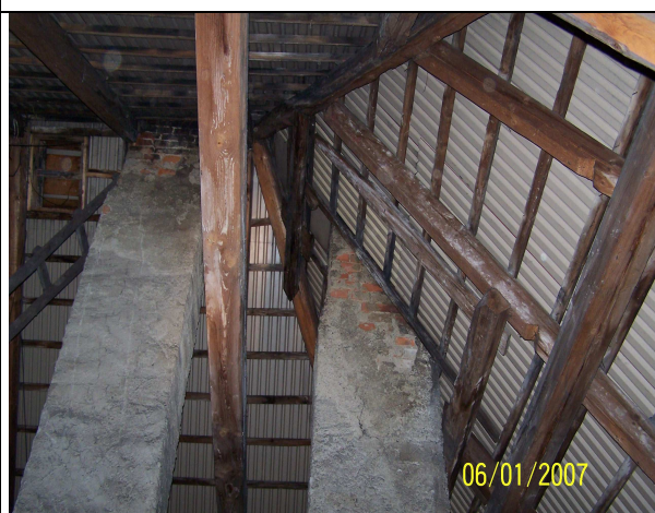
Elementy więźby dachowej
