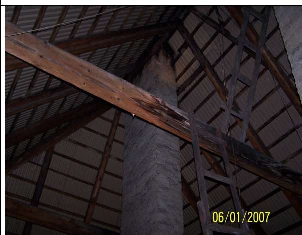
Elementy więźby dachowej
