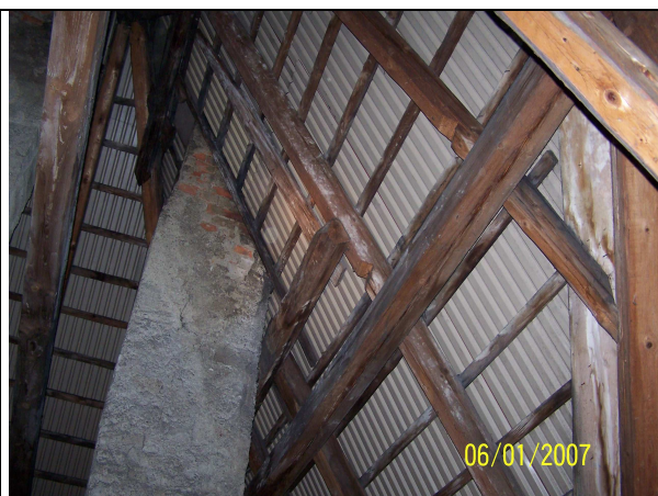
Komin i elementy więźby dachowej
