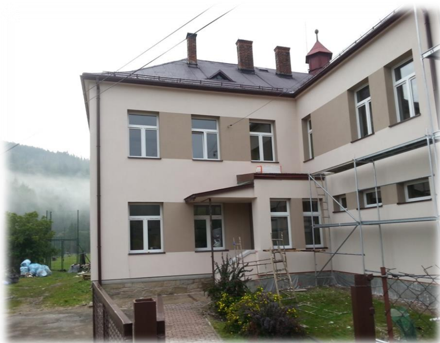
Budynek SP Rycerka Dolna po termomodernizacji.
