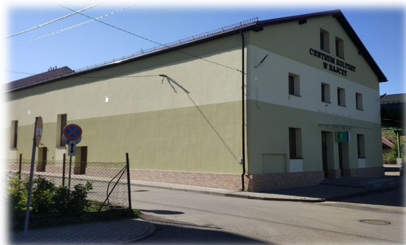
Budynek CKiS w Rajczy po termomodernizacji
