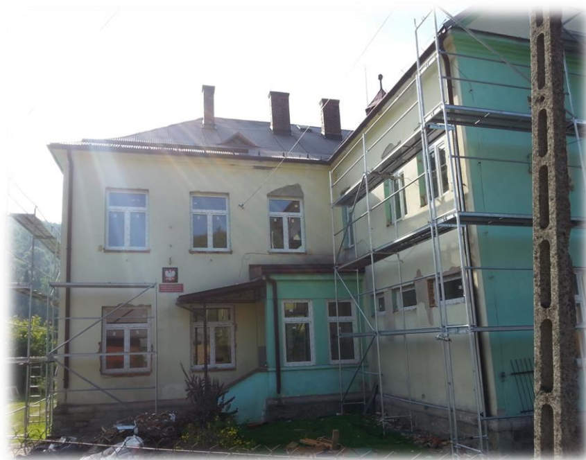
Budynek SP Rycerka Dolna przed termomodernizacją.
