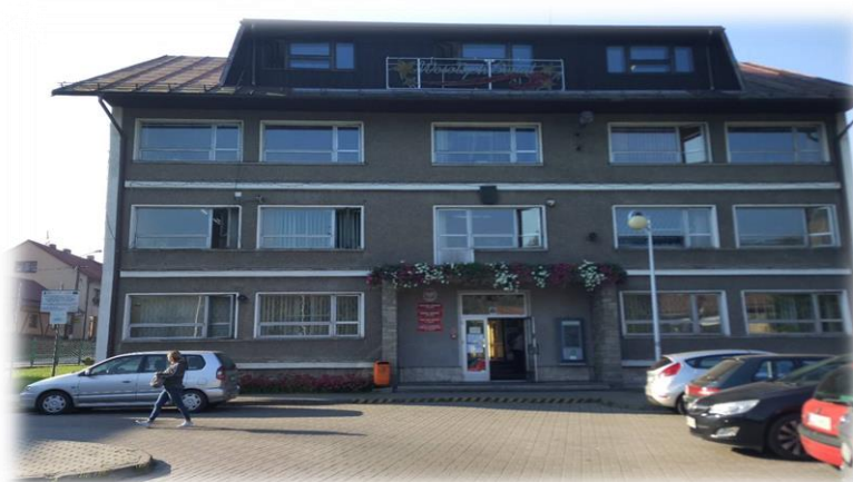
Budynek Urzędu Gminy w Rajczy przed termomodernizacją.
