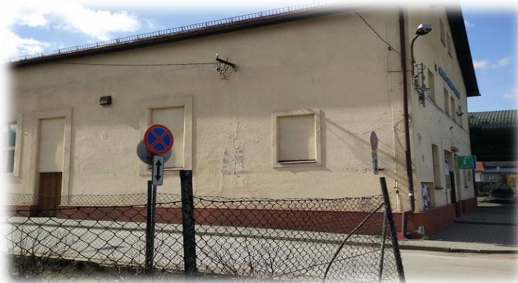
Budynek CKiS w Rajczy przed termomodernizacją.
