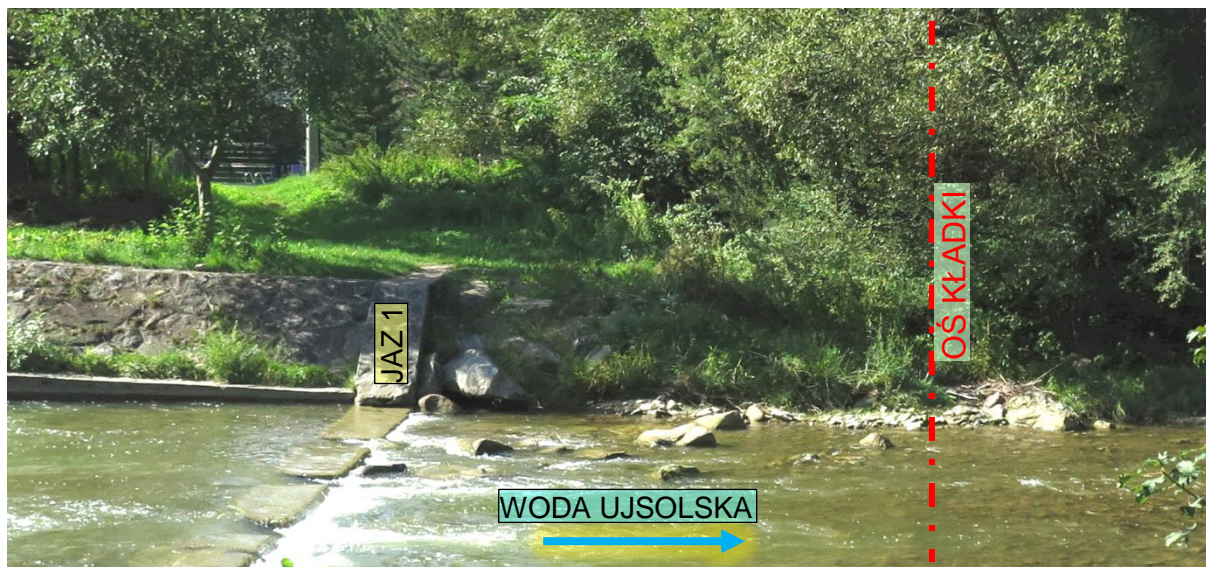
Widok na lewy brzeg w rejonie projektowanej kładki
